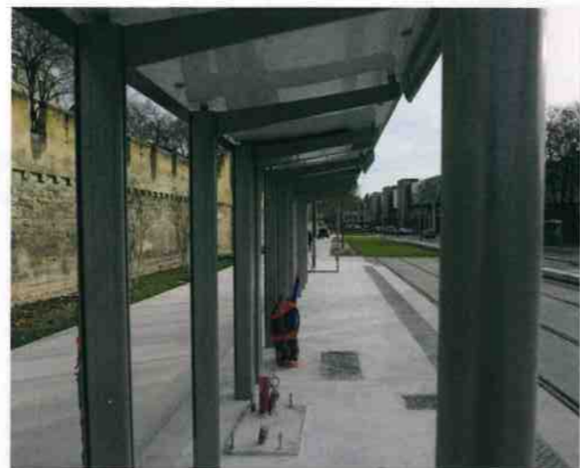
Les stations ont été aménagées pour accueillir le tramway à partir du 19 octobre.
